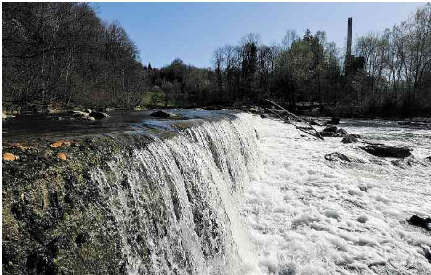
Die Wasserkraft der Sitter vermag ebenfalls Elektrizität zu erzeugen.
